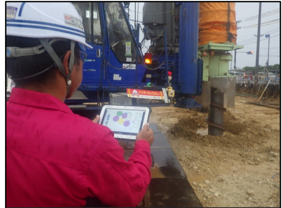
写真-5 Picture Eye による管理状況
