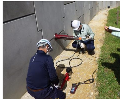
写真-1 現場引抜き試験の実施状況
