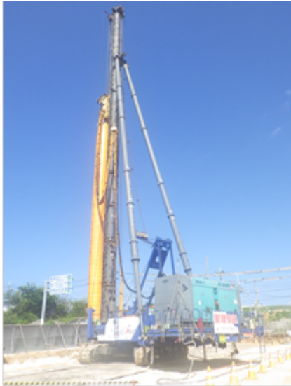
写真-3 エポコラム Taf 工法の施工状況
