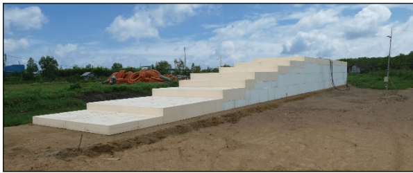
写真-3. EPS ブロック設置完了
