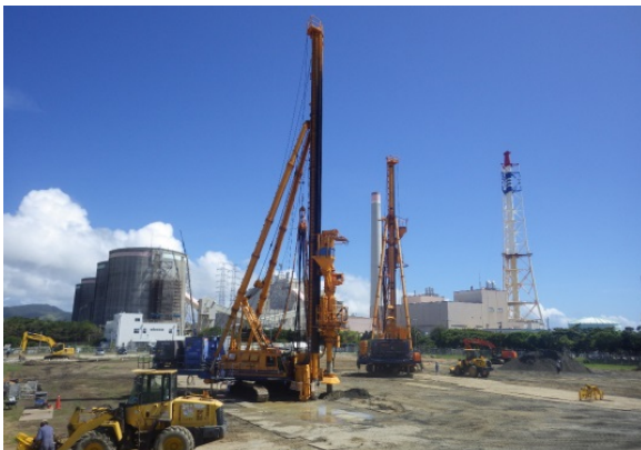
写真-1. 液状化対策施工状況
