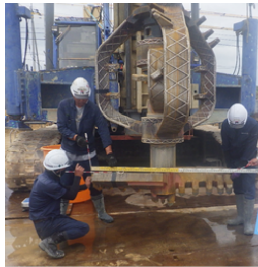
写真-1 エポコラム Taf 工法攪拌翼（翼径φ1.6m例）
