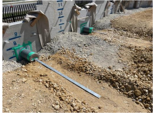
写真-2 KDパネルの現場設置状況
