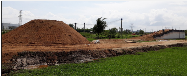
写真-4. 試験盛土 完成全景
