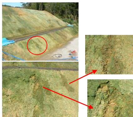
(b) 法面内部より浸透水が浸み出している状況
