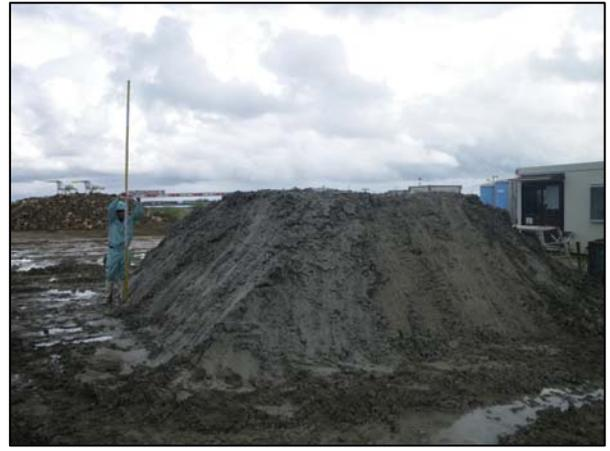
図-9 施工中の排土量の確認
