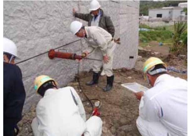
写真 - 5 ストリップ引き抜き試験状況
